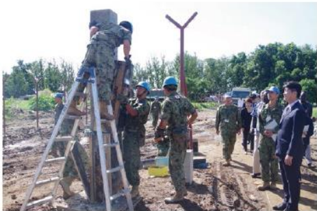
南スーダンにてジュバ河川防護柵設置作業を視察する石川防衛大臣政務官
