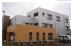
木造3階建住宅
