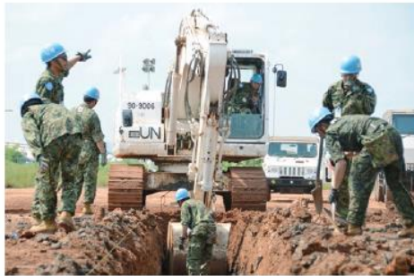
南スーダンで側溝の整備を行う派遣隊員
