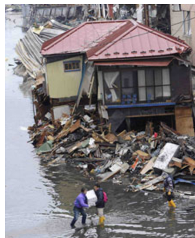
地震発生から4日後、倒壊した家屋から家財道具を運ぶ人々。宮城県、気仙沼市。写真提供：共同通信
