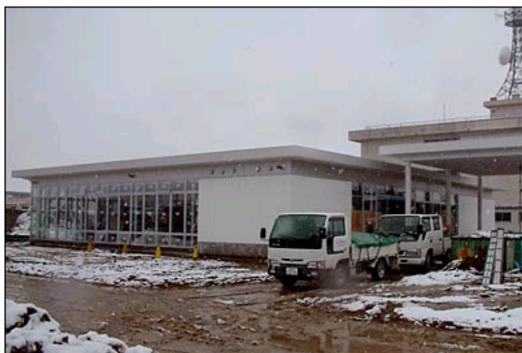
建設が進む県央医師会応急診療所
